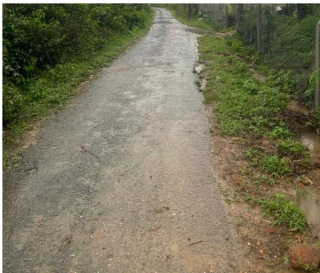
Hình 1. 2. Tuyến đường nhựa đi vào mỏ
