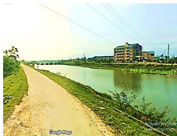
Kênh T1 đoạn đã hoàn thiện
