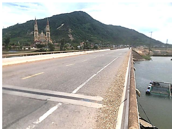
Hiện trạng cầu Tây Yên đoạn nâng cấp, mở rộng thuộc Quốc lộ 12C
