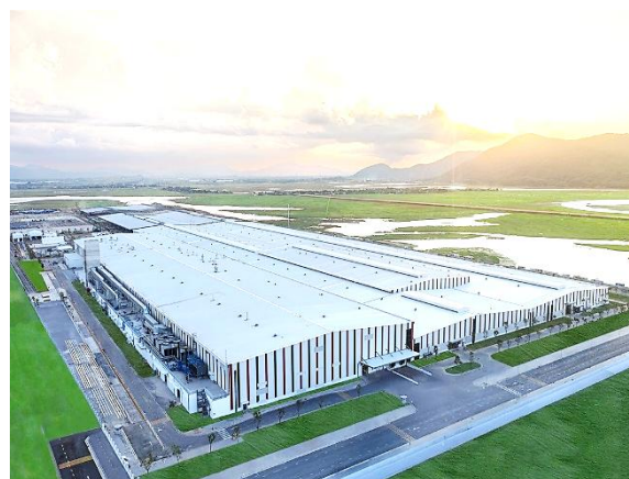
Nhà máy Vinfast Hà Tĩnh
